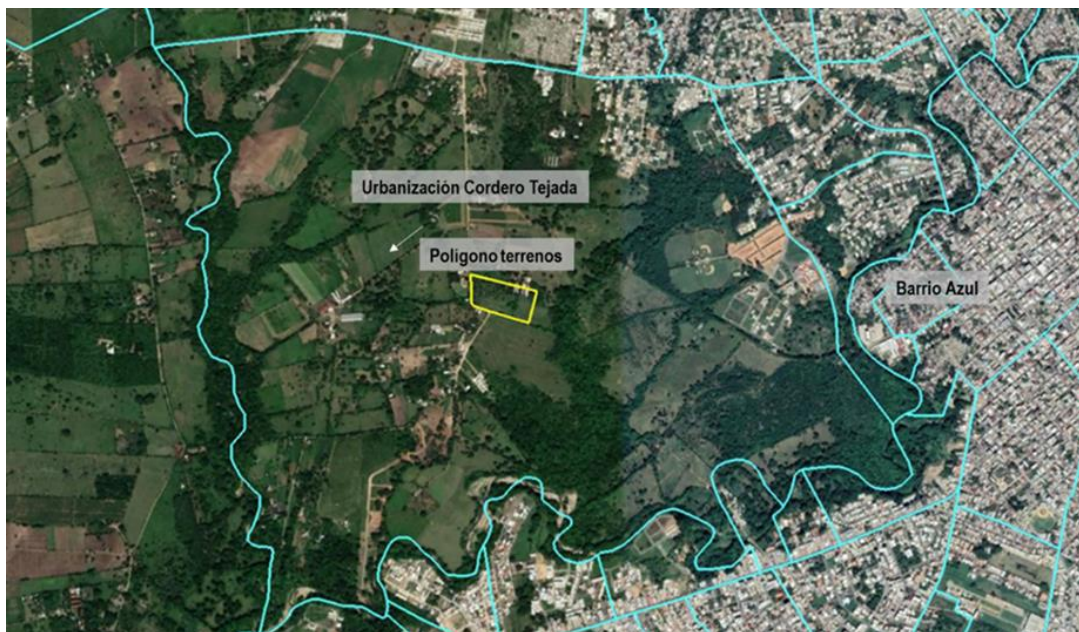
Ilustración 1: Localización del subproyecto Construcción Nuevo Hábitat
